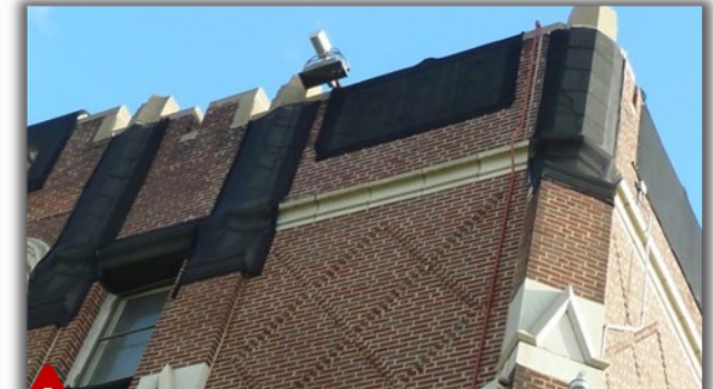
暂时固定住的腐蚀砖块
