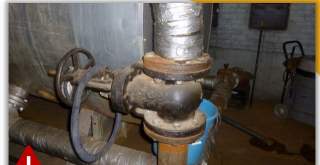
供热分配管道系统损坏
