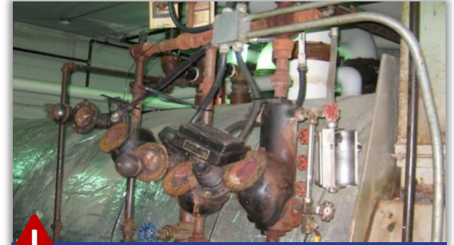
分配管道系统被腐蚀
