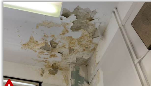
石膏/内部装修破损
