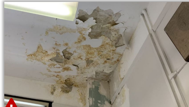
Averías en estructuras de yeso/acabados interiores
