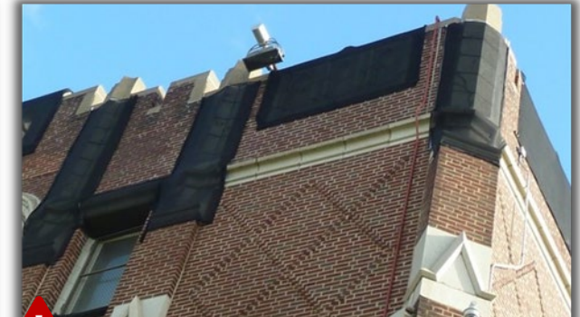
Estabilización temporal de la erosión en ladrillos
