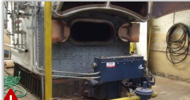
Calentador obsoleto (uso extendido más allá de su vida útil)
