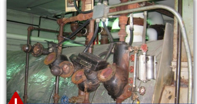
Corrosión en las tuberías de distribución
