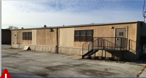
المبنى المعياري الموجود
