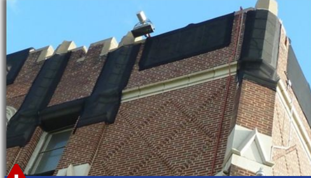
استقرار مؤقت لتآكل الطوب
