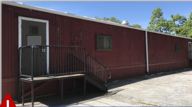
المبنى المعياري الموجود
