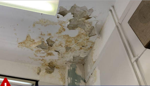
الجص/التشطيبات الداخلية المعطلة
