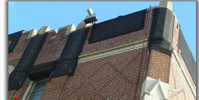
! Estabilización temporal de la erosión en ladrillos
