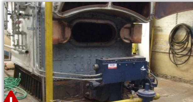
Przestarzały bojler (po przewidywanym okresie trwałości)
