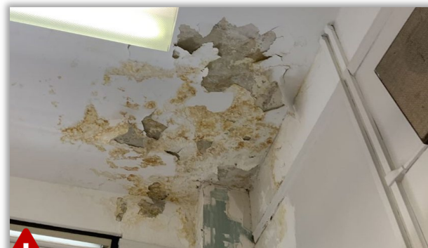
Zniszczenie tynku/wykończeń wewnętrznych
