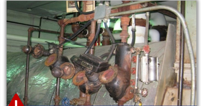
Korozja rur przewodzących
